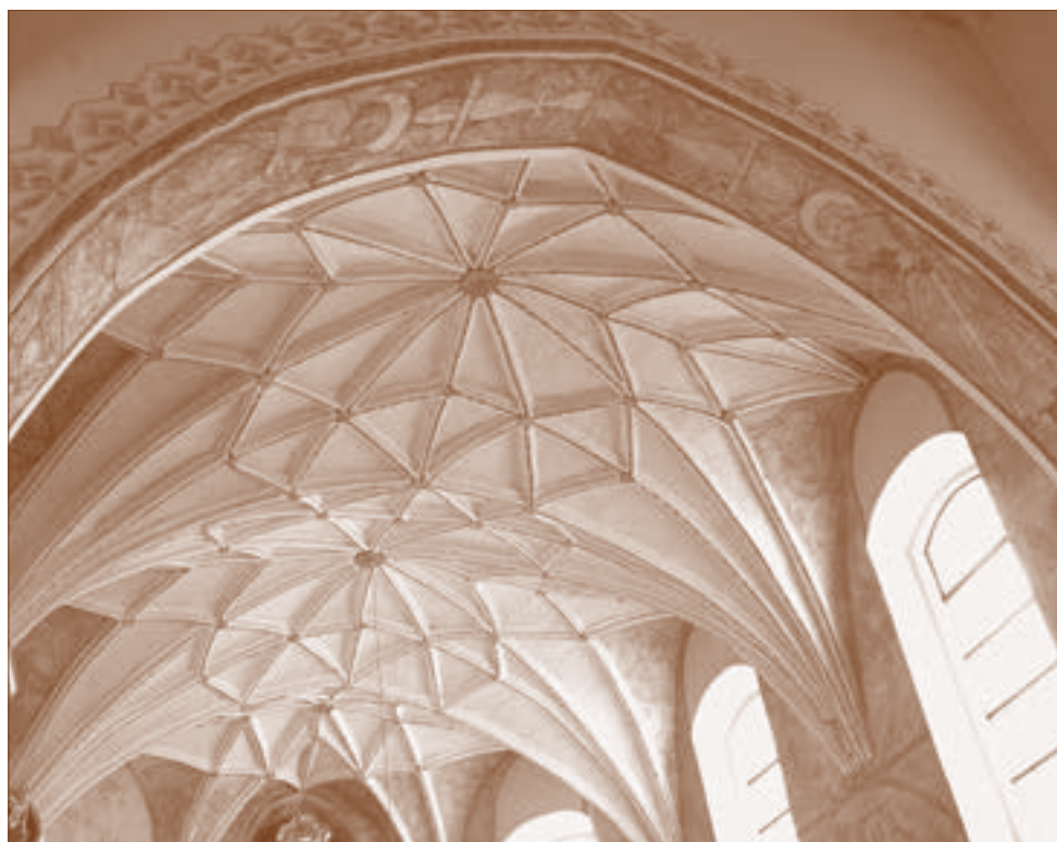
Sklepienie prezbiterium kościoła z postaciami patronów na łuku tęczowym
