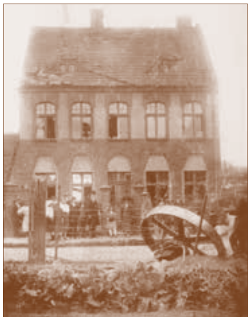
Katastrofa w elektrowni (1923 r.)
