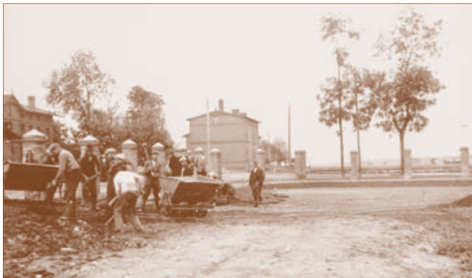
Budowa parku miejskiego przy ul. Dworcowej (1938 r.)
